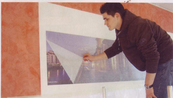
Nach dem Einbetten und Anpressen des Motivs in den nassen Untergrund kann die Polyesterfolie nach einer Trocknungszeit abgezogen werden.
